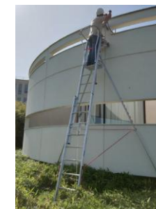
Intervention avec une échelle sécurisée
